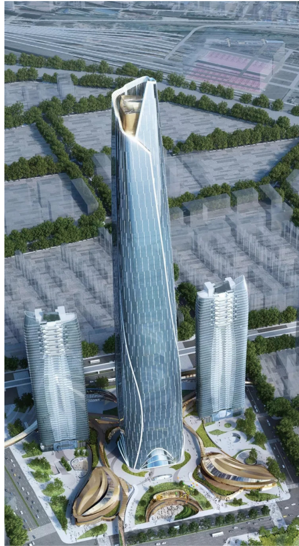
武汉周大福金融中心地下空间工程
