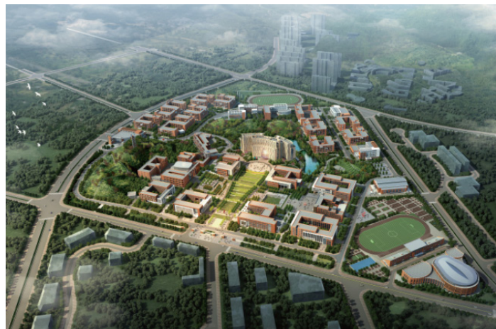
遵义师范学院新蒲校区能源站项目 服务校园建筑面积40万平方米，项目运营期20年
