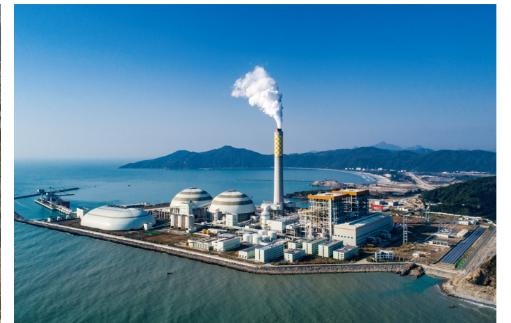
华润电力海丰电厂桩基工程
