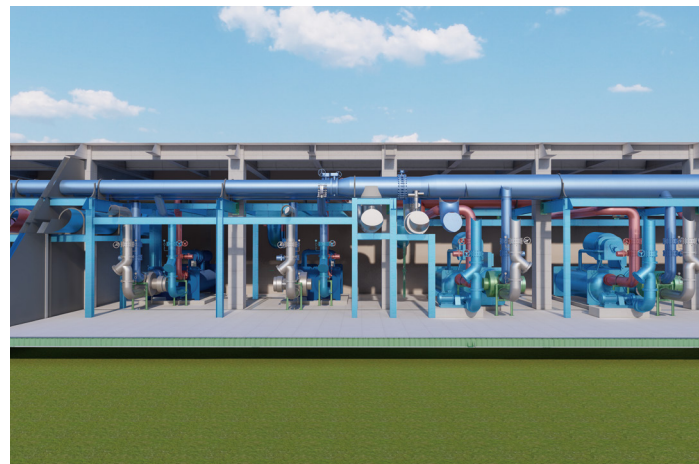
湖北首座江水源能源站——武汉二七滨江商务区绿色低碳能源站
