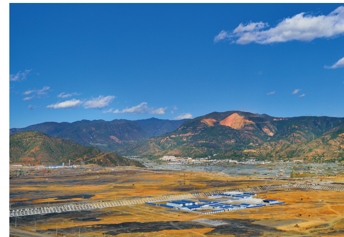
玉昆钢铁集团产能置换升级岩土工程一体化项目
