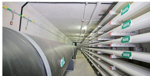
珠海横琴新区市政基础设施城市综合管廊工程 国内综合管廊领域第一个鲁班奖
