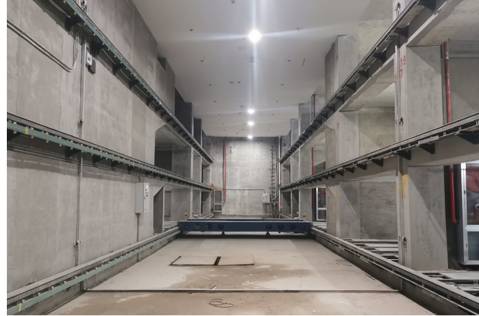
金涛地产大厦及江岸区公共地下车库 5层机械停车场，开挖深度17.5米，项目周边环境复杂，离8层民房最近仅5米，距离长江约200米
